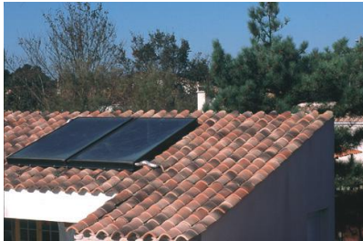
Capteurs solaires intégrés sur toiture neuve, Chéray
