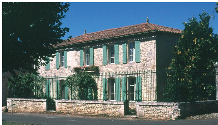
Sur une maison saintongeaise, le piquage de l'enduit de façade est un non-sens technique autant qu'esthétique, Saint-Sornin.
