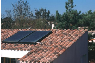
Capteurs solaires intégrés sur toiture neuve, Chéray
