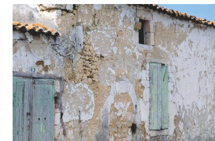
La vêtue traditionnelle : moellons tout venant, enduit à la chaux de couleur du sable et badigeonné au lait de chaux, Souhe, Le Gua
